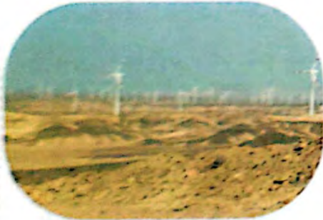
محطة جبل الزيت
